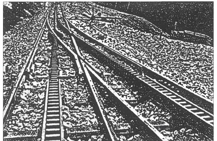
Zahnstange der Bauart Riggenschach im Weichenbereich.
